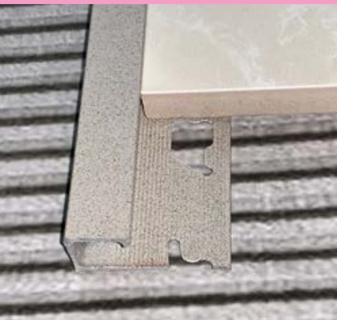
Chiusura perimetrale a pavimento/ Ground covering edging
